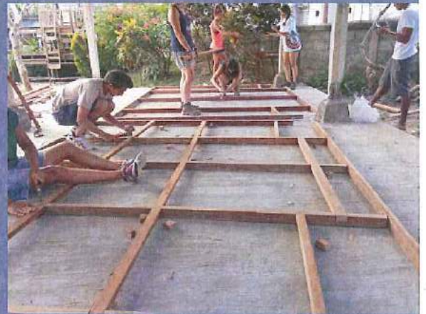
Construction de la structure
