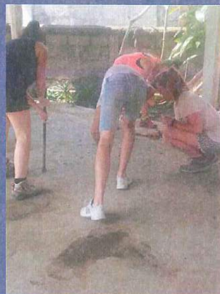
Perçage de l'ancienne dalle
