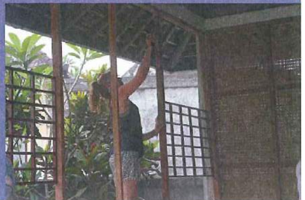
Montage des murs
