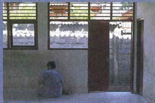
Rebouchage des trous
