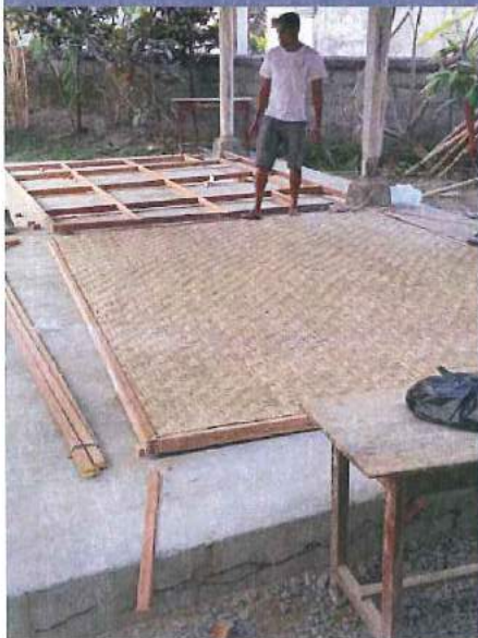
Mise en place de la natte
