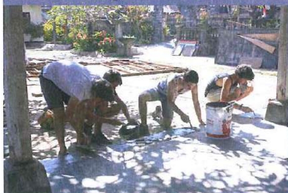
Étalage du béton
